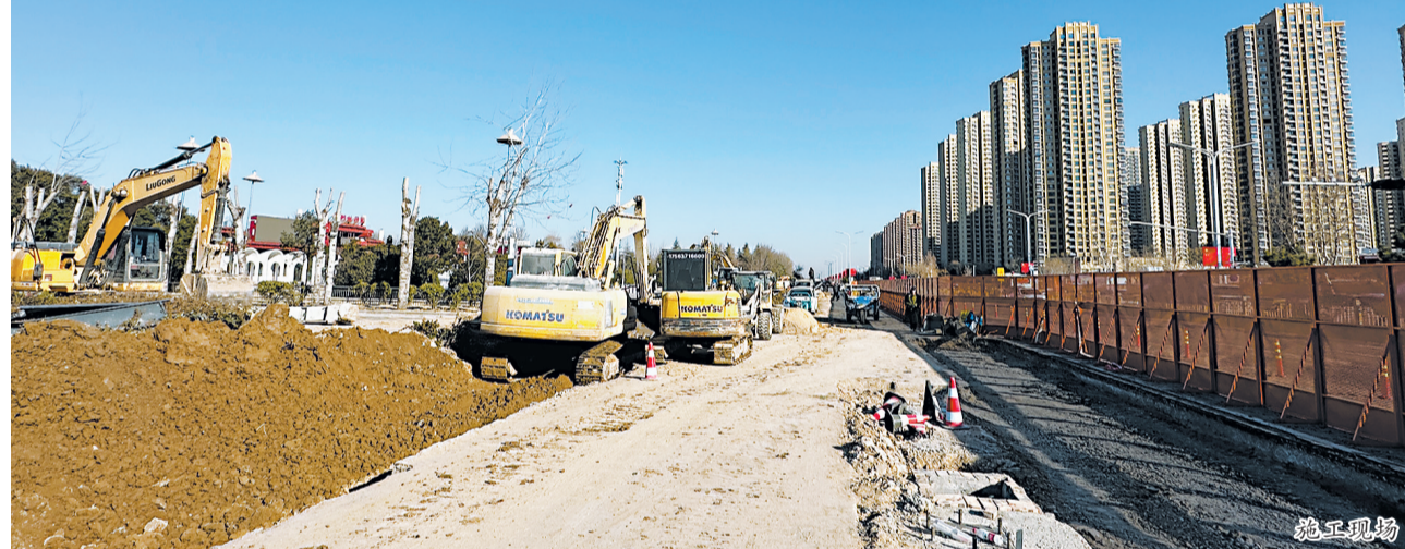
挖掘机械轰鸣作业
